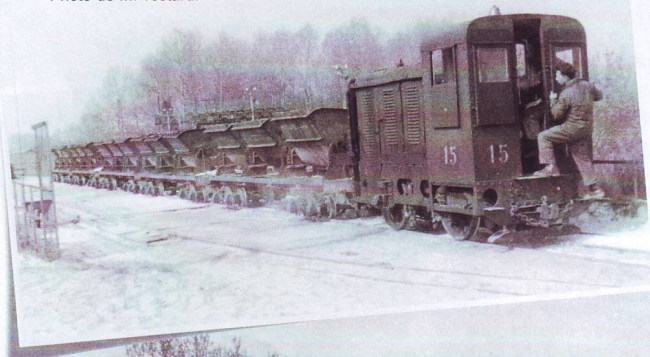
Locotracteur Dick Kerr n°15 quitte le déversoir à Nemours pour la Sablière de Bonnevault, vers 1963. Photo de M. Testard.
