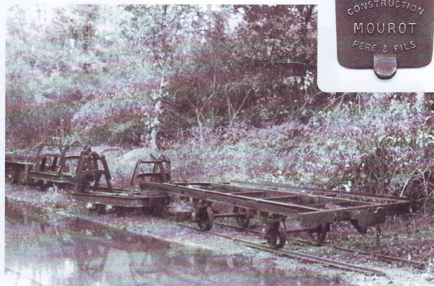
▲ Au premier plan : le premier châssis de baladeuse en construction. Tout au fond à gauche, on aperçoit le châssis du Deutz avant sa reconstruction.
